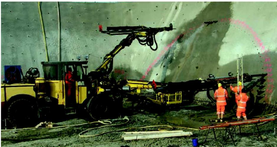
*Emcor ofrece un este sistema de tratamiento del terreno en tubos de acero que van desde los 76.10 a los 139,7 mm.*
